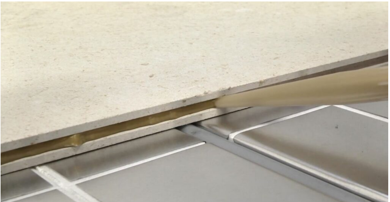
Verspreid de lijm goed in Mess en Groef verbinding
