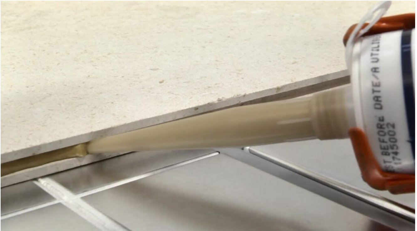
Gebruik de lijm over de gehele verbinding
